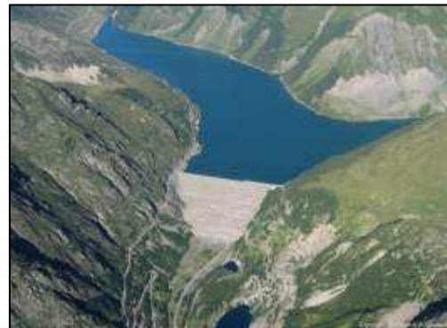
barrage de Grand Maison
